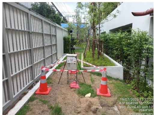
รูปที่ 9 ติดตั้งเครื่องตรวจวัดคุณภาพสิ่งแวดล้อม (คุณภาพอากาศ ระดับเสียง เสียงรบกวน และความสั่นสะเทือน)
