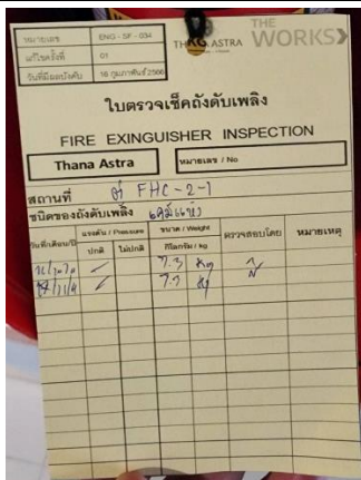
รูปที่ 13 ป้ายตรวจสอบสภาพพร้อมใช้งานถังดับเพลิง
